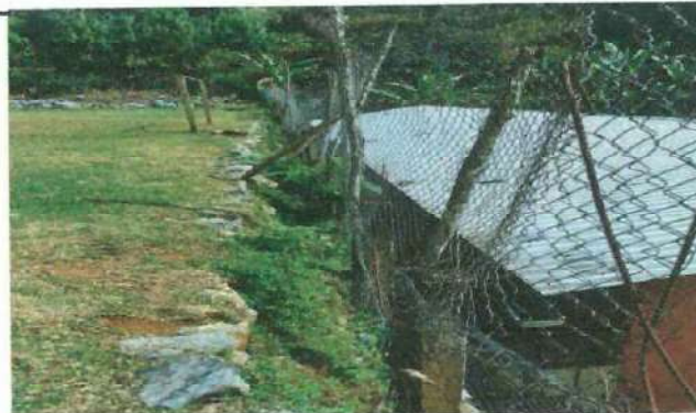
Foto 4: Cambio de madera por tubos galvanizados y mallas galvanizadas
